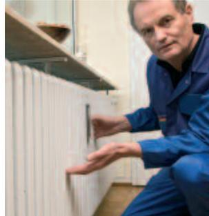
**10 Wärmeübergabe:** Die Inspektion der Heizkörperventile bzw. Raumregler wird mit einer Sichtprüfung in mindestens drei Räumen unterschiedlicher Größe oder Nutzung vorgenommen.
