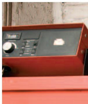
**6 Regelung:** Auf Basis einer Sichtprüfung werden für die vorgefundene Kesselregelung (z. B. ohne Regelung, raumgeführte oder außentemperaturgeführte Regeleinrichtung) abgestufte Punktzahlen vergeben.
