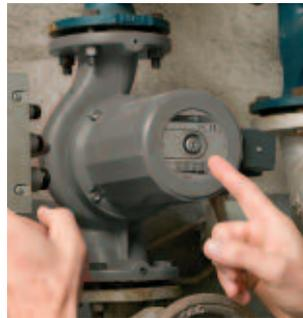
**8 Heizungspumpe:** Die Bewertung der Soll-Leistungsaufnahme erfolgt wenn keine Planungsdaten vorliegen, durch Abschätzungen mit Hilfe eines grafischen Verfahrens.
